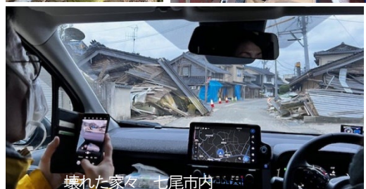
壊れた家々 七尾市内
